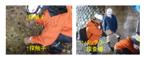
(例) 超音波探査で空洞を測定
