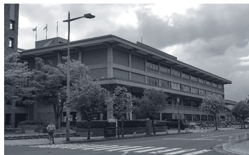
写真1 弘前市庁舎前川本館
