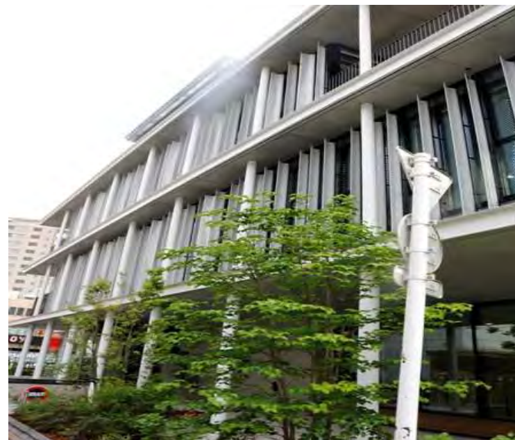
写真11. NOTIAファサード/特徴的な縦ルーバー
