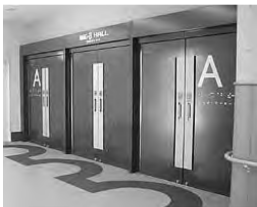
ドアの軌跡を描いた床のパターン
