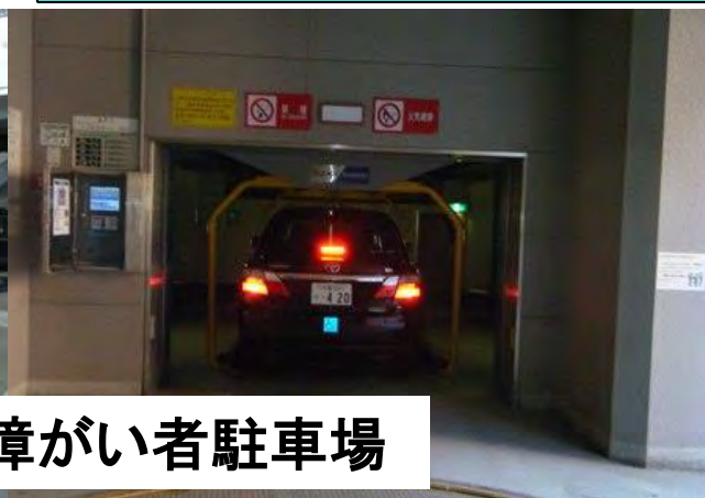
② エレベーター
