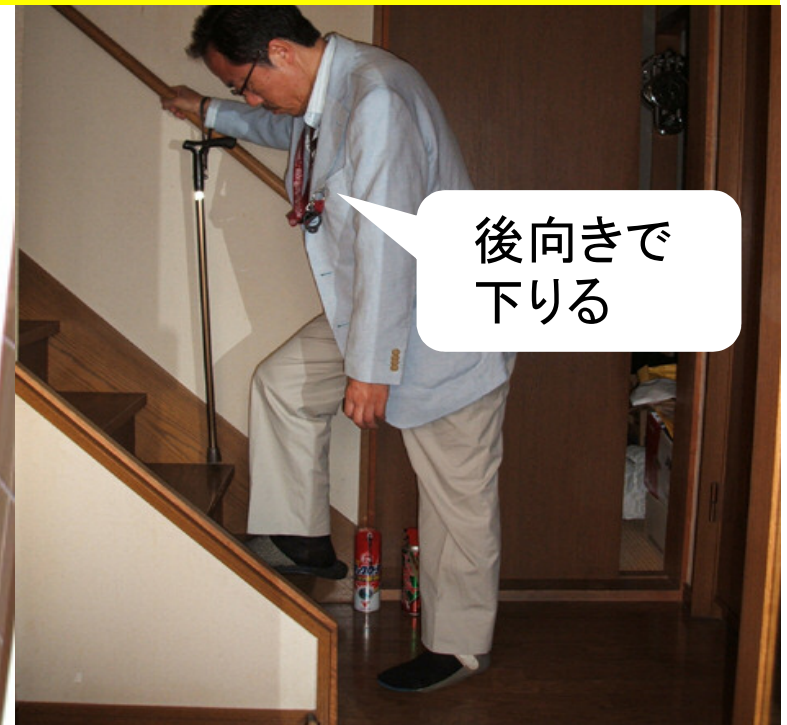
(2) 階段手摺は右側のみ
