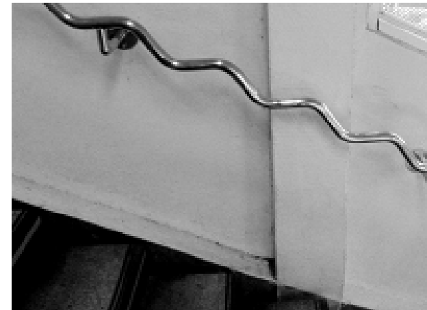
手摺の工夫。体重を掛けやすい
