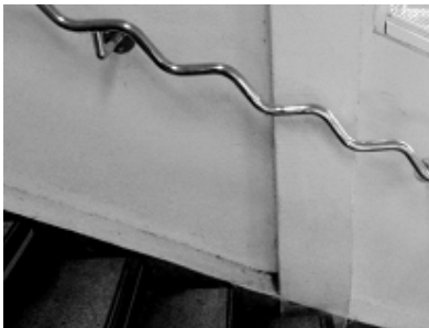
波型の手すりの工夫。降りる時には体重を支え、上る時には引き上げることに効果がある。
