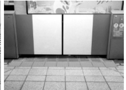
多くの視覚障害者がホームから転落した経験を持つ。防護壁・扉、あらゆる人にとって安全。
