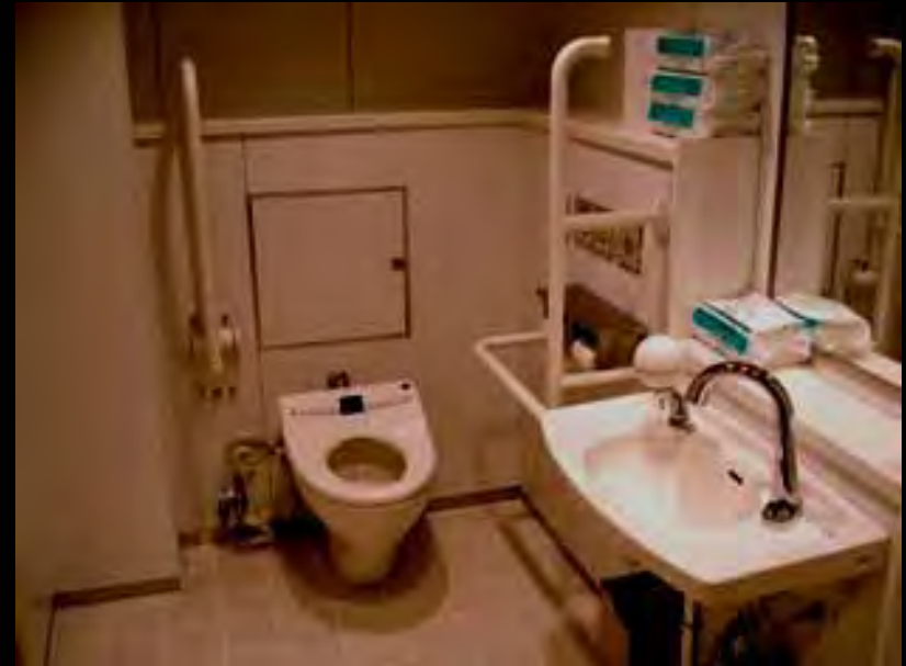
多目的トイレを新たに設置
