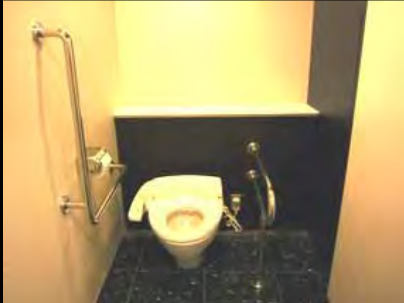
ビル標準車椅子対応トイレ
