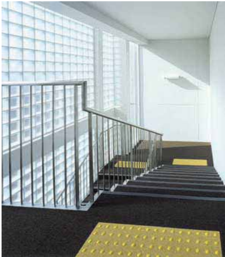
ガラスブロックから自然光が入る明るい階段
