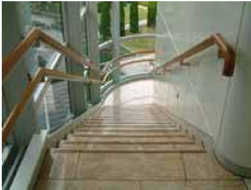
自然光の入る明るい階段・手すり
