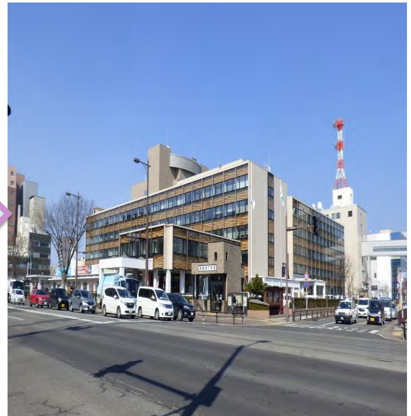
改修後2018年 （平成30年）
