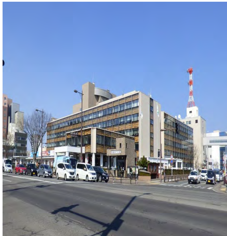
改修後2018年 （平成30年）
