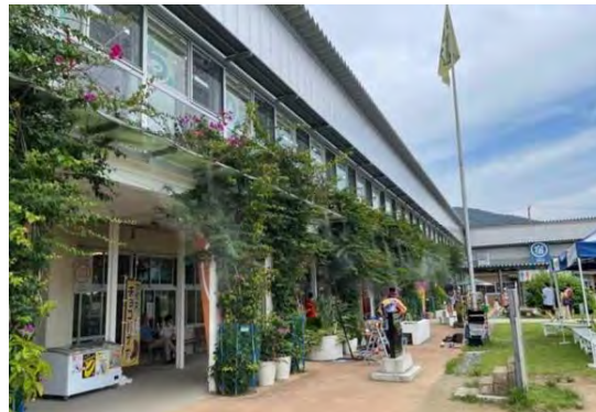
旧教室棟の1階はテナントスペース、2階が宿泊室、2階の既存バルコニーの前面に「まちの縁側」を増設。1階部分は雨よげが可能なピロティに変身
