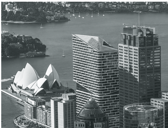
写真2 既存躯体を利用して建設されたアップサイクルビル AMP Quay Quarter Tower
