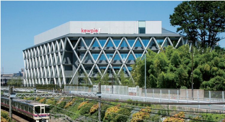
東京都調布市にある仙川キューポート
