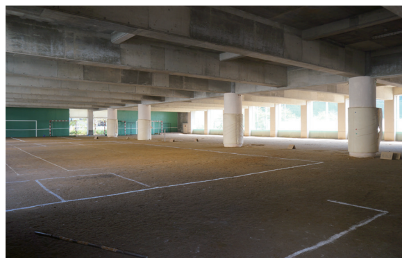
改修前 体育館1F
