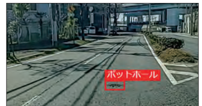
写真 損傷検出例
