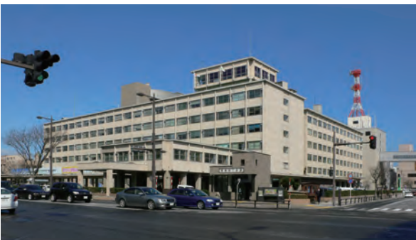
改修前の県庁舎
