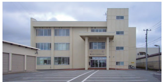
エレベーターも増設した改修後の庁舎(むつ健康福祉庁舎)
