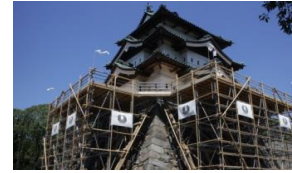
【石垣修繕工事】
