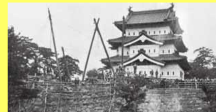
1915年頃の石垣修理工事の様子
