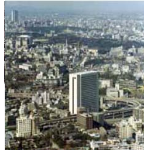
竣工時の写真。左奥は京王プラザホテル。
