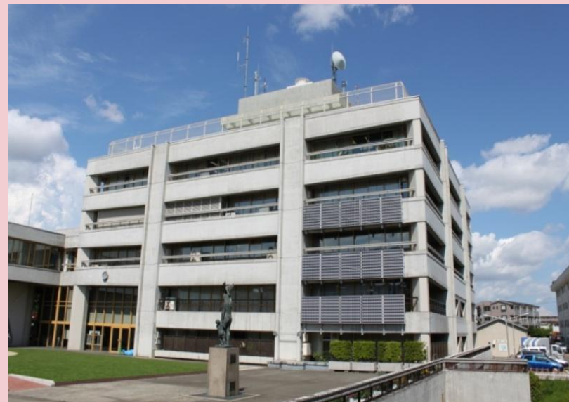
三鷹市役所本庁舎（西壁に太陽光発電パネル）
