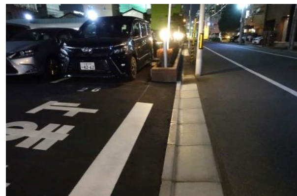
改修後(門扉撤去、駐車場舗装)
