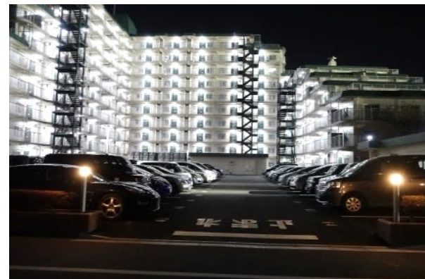
改修後(LED照明、駐車場舗装)
