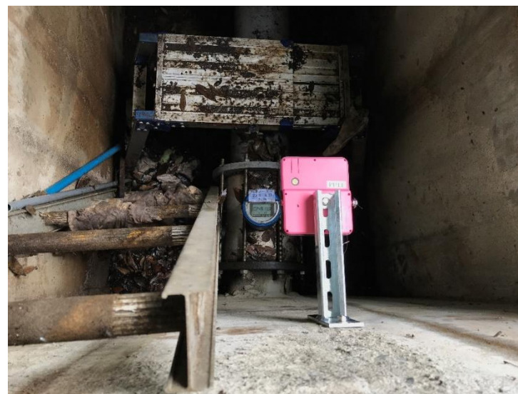
〈マンホール内〉
