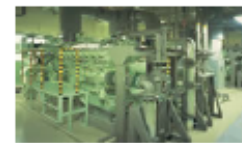
1,000kWクラス ガスエンジン発電設備
