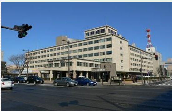
改修前の県庁舎 (平成26年3月撮影)
