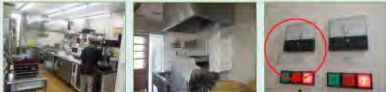
給気ファンを停止し、第3種換気方式として運転。隣接するレストランエリアは開放空間なのでOK!
