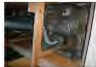
※ 浴室脱衣所天井裏(図面では全熱交換器だが、実態は換気扇、換気用ツーウェイファン)
