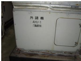
屋根については保護コンクリートにクラックが多数発生、伸縮目地部のシーリング材の破断等により、防水層に支障が生じており、階段室の一部で漏水により天井が落下。また、空気調和設備については、外部に発錆が見受けられるとともに、内部部品（熱交換器、送風機等）の発錆・劣化が確認。
