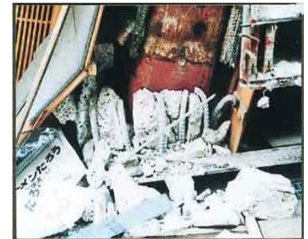
柱脚の破損
