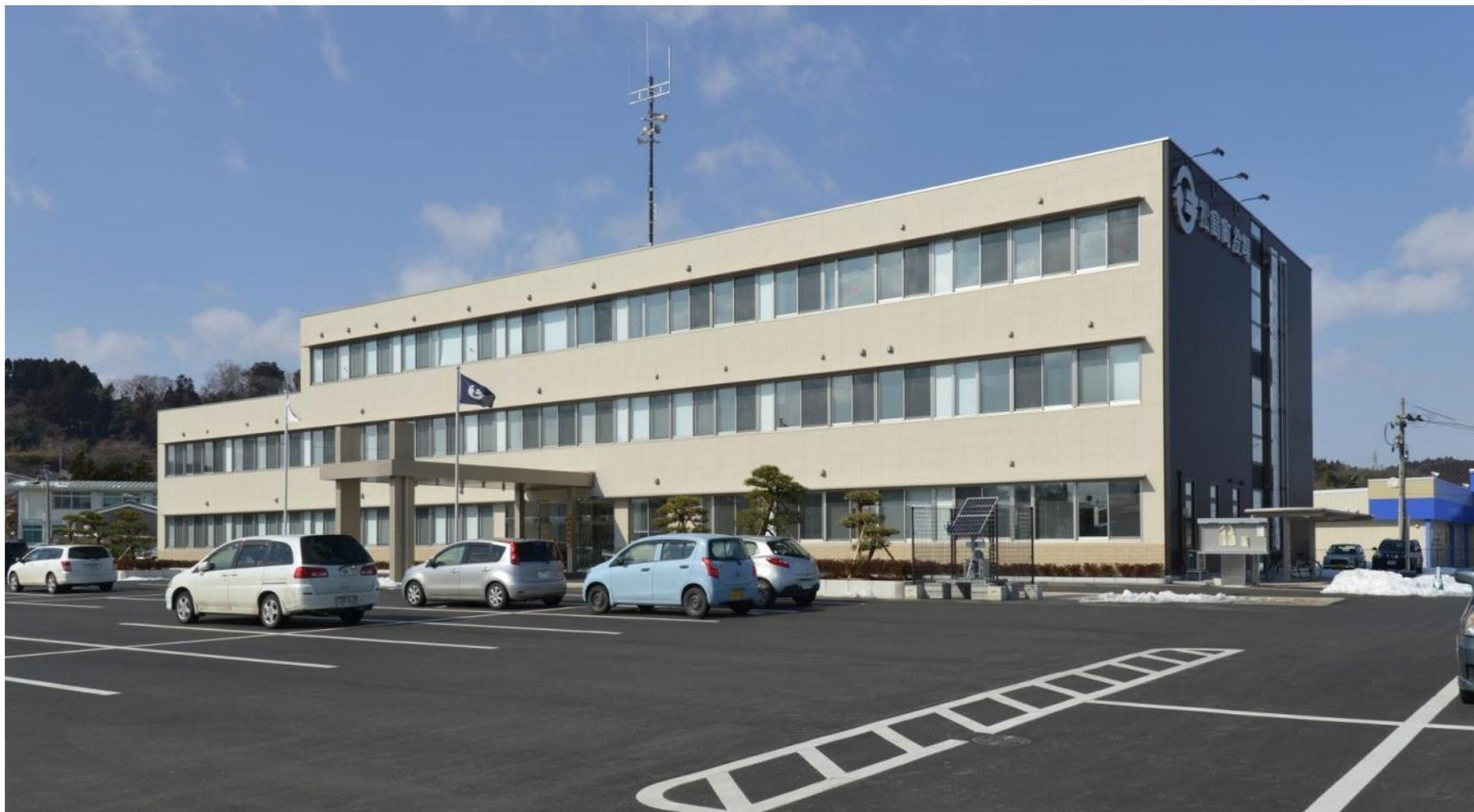
倒壊のおそれがある旧庁舎から一刻も早い移転を実現するため、短工期・コストパフォーマンス・機能性などのメリットを備えたシステム建築をデザインビルド方式で設計・施工しました。システム建築はリース対応も可能です。
