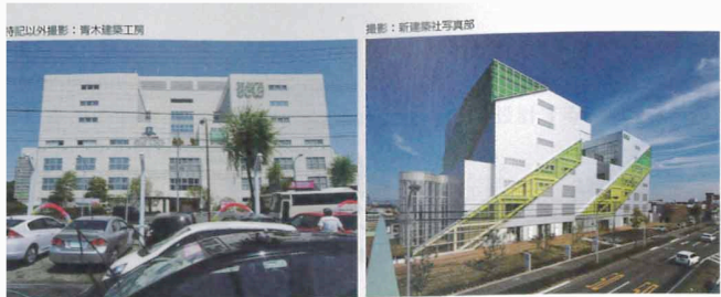
既存の状態。故・黒川紀章氏の設計により1981年に完成した。改修後。ベルト状のブレースで補強している。
