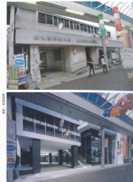
上:FTK BLD.既存の状態。商店街に面した医院だった。下:改修後。2棟に分離させ耐震性能を向上させた。
