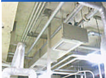
複雑な現場でも施工できる
