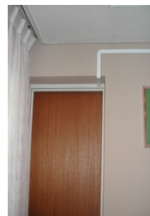
区画貫通を避けられない場合は、極力躯体の負担が少ない方法で工事を実施。左側写真はコンクリート壁を貫通せず、ドアの枠を貫通させた例。右側写真はコンクリート壁とドア枠の間に詰め込まれたモルタル部分を貫通させ、耐震に影響が無いよう実施した例。
