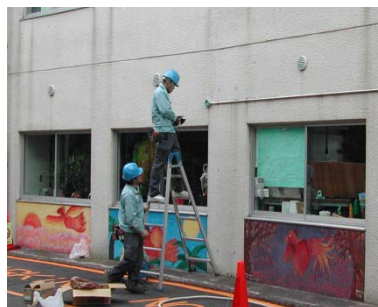
区画貫通を極力避け、既存の経路などを最大限生かした形で配線
