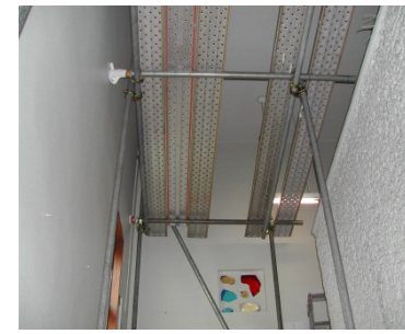
高所作業などの場合は足場を設置致
