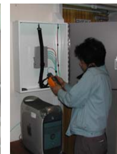
工事終了後、各種試験を実施し、結果報告書として提出。また配線した経路は図面に落とし、完成図書として施設管理者に渡し、以後のメンテナンス資料として、管理。
