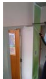
区画貫通を避けられない場合は、極力躯体の負担が少ない方法で工事を実施。左側写真はコンクリート壁を貫通せず、ドアの枠を貫通させた例。右側写真はコンクリート壁とドア枠の間に詰め込まれたモルタル部分を貫通させ、耐震に影響が無いよう実施した例。
