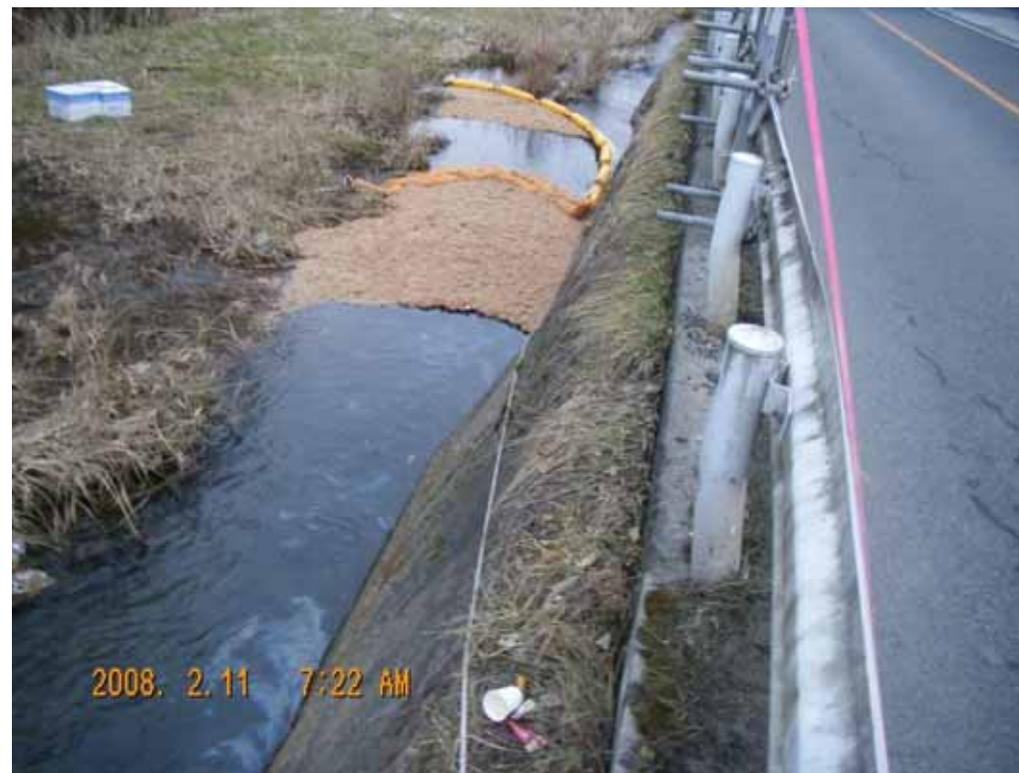
地下タンクから流出したガソリンが地下水に入り、近くの川に流れ出た
